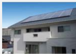
住宅用太陽光発電システム
