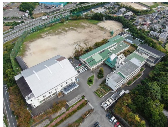
太陽光発電設備等導入予定施設である篠栗北中学校 全景、サニックスエンジニアリングにより撮影
