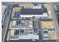
廃液処理工場
