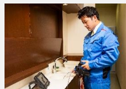
ビデオスコープによる水道管検査
