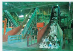
プラスチック資源開発工場
