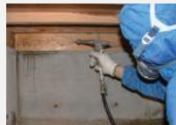
白蟻防除施工
