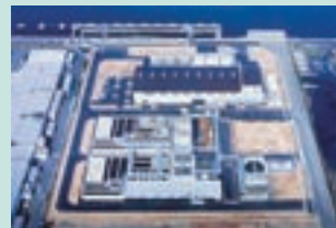
ひびき工場 (廃液処理工場)
