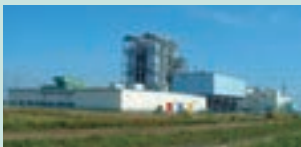
(株)サンニクスエナジー 苫小牧発電所
