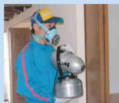
害虫防除施工
