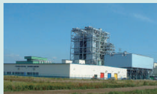
サニックスエナジー 苫小牧発電所
