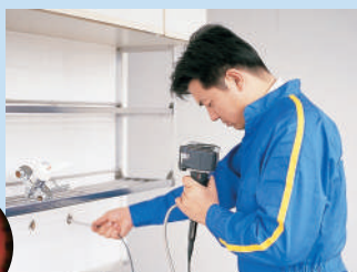
ファイバースコープによる水道管検査
