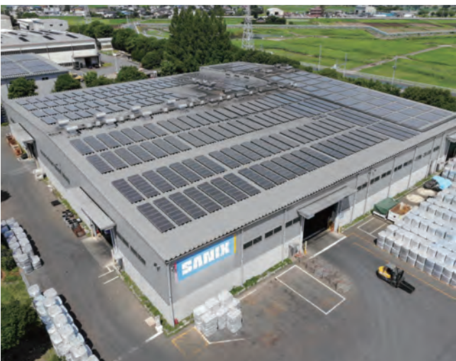
設計から施工まで自社で行える強みを生かし、自社施設への自家消費型太陽 光発電導入も進めている(写真は太田工場=プラスチック資源開発工場の例)。自 家消費型太陽光発電のモデルケースとして、太陽光発電事業にも生かす。
