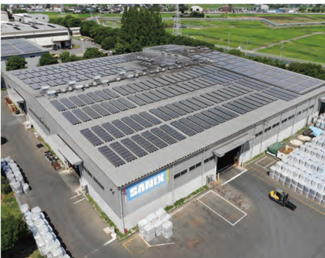
設計から施工まで自社で行える強みを生かし、自社施設への自家消費型太陽 光発電導入も進めている(写真は太田工場=プラスチック資源開発工場の例)。自 家消費型太陽光発電のモデルケースとして、太陽光発電事業にも生かす。
