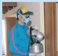
害虫防除施工
