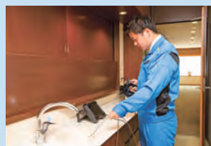
内視鏡による給排水管内部の検査
