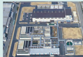
ひびき工場(廃液処理工場)
