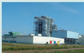
サンックスエネルギー 苫小牧発電所
