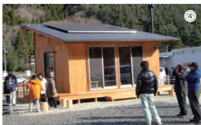
岩手県盛岡市被災地支援施設建設プロジェクトに協賛し、大槌町の集会所に太陽光発電を提供(2011年)。
