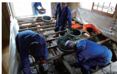
福岡県東峰村において、浸水住宅の床下泥土除去・防疫消毒等、復旧支援を実施(2017年)。
