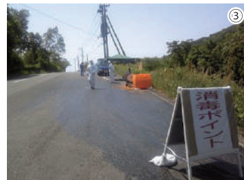
宮崎県都農町にて、通過車両などの殺菌施工を実施(2010年)。
