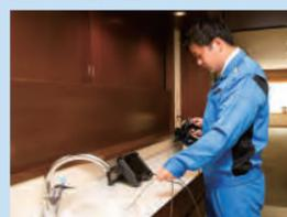
内視鏡による給排水管内部の検査
