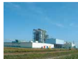
サニックスエナジー苫小牧発電所
