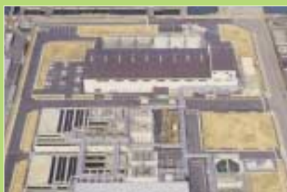
有機廃液処理施設 ひびき工場 受入れた有機廃液をク ロースド処理し、処理工 程での副産物をセメント 原料、工場用水など再 資源として活用する日本 最大級の処理施設です。
