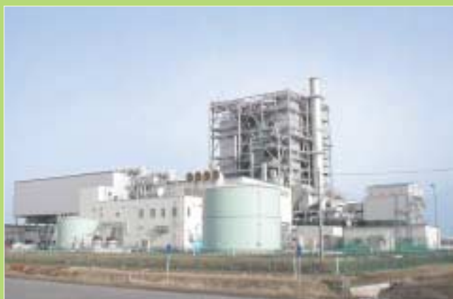
サニックス循環型発電システム苫小牧工場 プラスチック資源開発工場で加工した燃料プラスチックを元に、 環境にやさしい高効率の発電を行っています。
